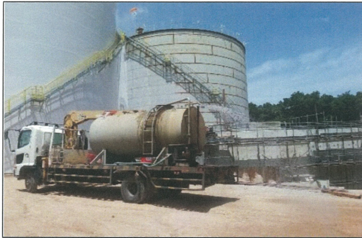
รูปที่ 1-1 รถฉีดพรมน้ำบริเวณพื้นที่ก่อสร้าง
