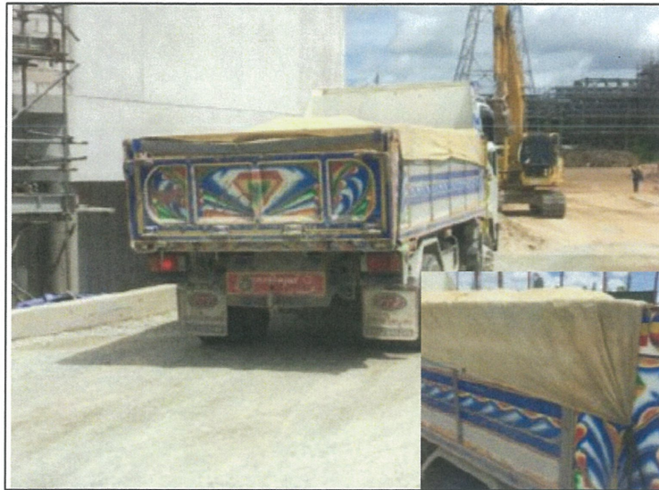
รูปที่ 1-2 รถบรรทุกวัสดุก่อสร้างมีการปิดคลุมด้วยผ้าใบ
