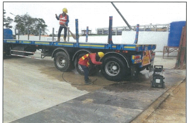
รูปที่ 4-3 ล้างตัวรถและล้อรถบรรทุกให้เศษดินทราย หลุดก่อนออกนอกพื้นที่โครงการ
